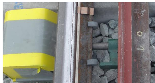
Obr. 4.6.4.2.5 Odtlačný zámek – pro zamčení se háček zámku u odlehleho jazyka překlopí do svislé polohy
