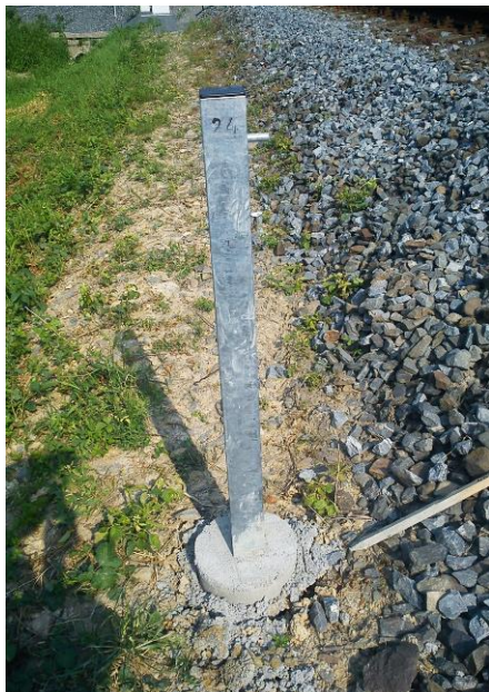
Obr. 2.3.1.12 – Podezřelá zajišťovací značka
