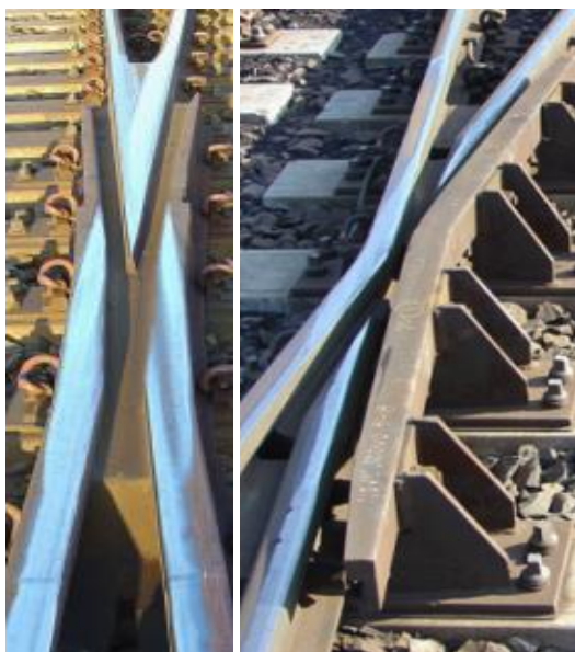
Obr. 4.6.2.5.1 Jednoduchá a dvojitá srdcovka
