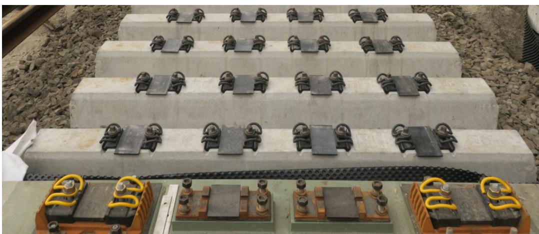
Obr. 4.3.2.10b Pražec BV 08Z (tzv. „přechodový“)
