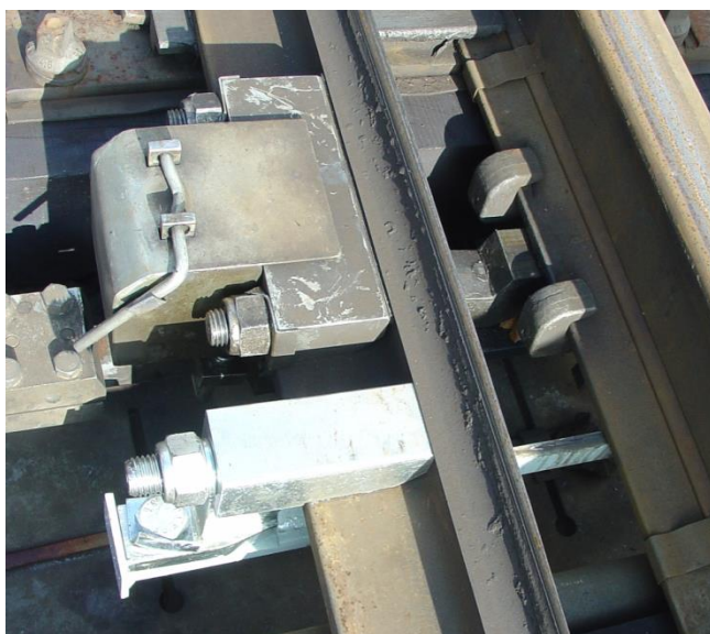
Obr. 4.6.5.1.16 Přidržovač jazyka – pohled shora
