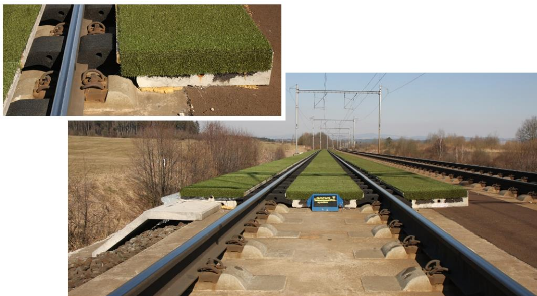
Obr. 4.9.1.2.2 kolejový absorbér na BA-S (ze syntetického recyklátu STERED®)
