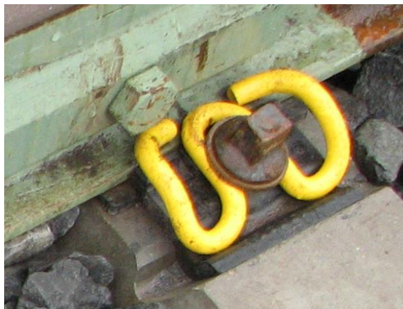
a v konstrukci LIS S 49 se svěrkou Skl 1K (standardně bez barevného rozlišení)
