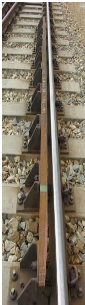
Obr. 4.6.2.5.17 Přídržnice profilu Kn 60
