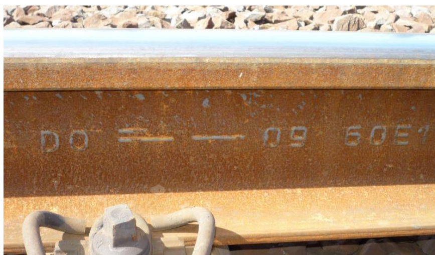
Obr. 4.5.5.1 Naválcované znaky na stojině kolejnic (příklad výrobce voestalpine)
