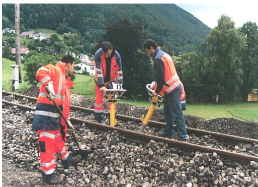
Obrázek 14.3.4.4 – Podbíjení pražců motorovými podbíječkami Robel 62.05
