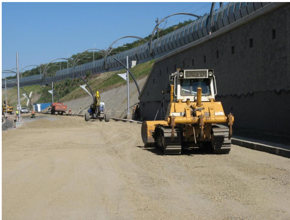
Obr. 3.9.1. - Zabudování konstrukční vrstvy ze štěrku
