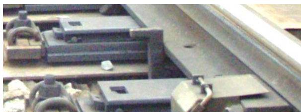
Obr. 4.6.4.2.4 Výměnový zámek – zabezpečuje přilehlý jazyk (háček zámku je zdvižen před patou jazyka)
