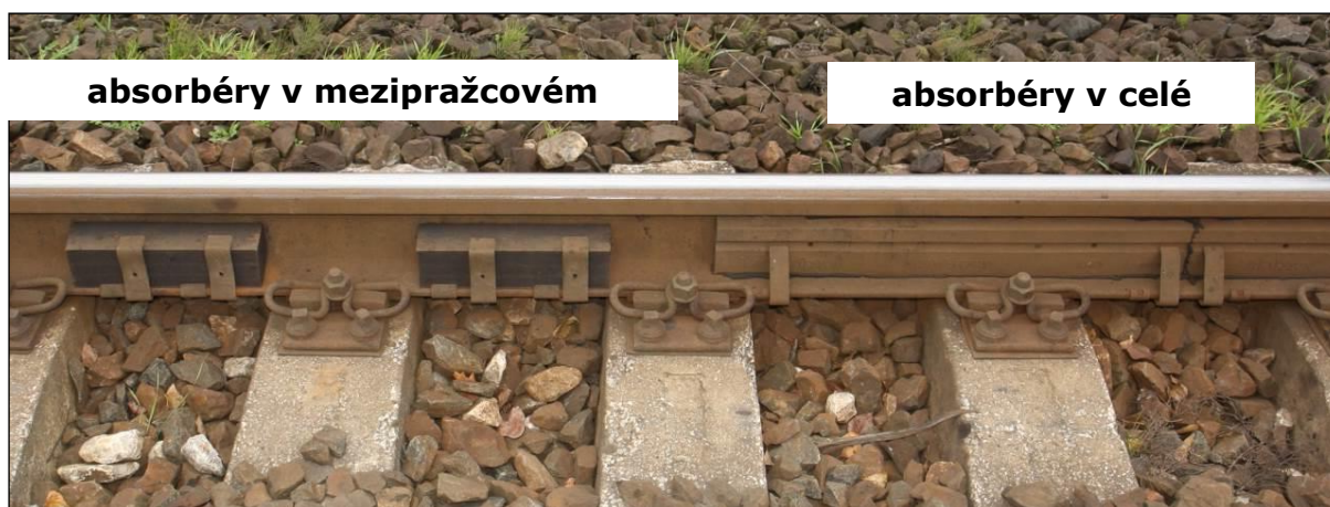
Obr. 4.9.1.1.1 Základní typy kolejnicových absorbérů
