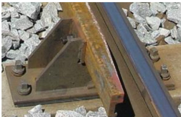
Obr. 4.6.2.5.19 Svařovaná podkladnice k přídržnici
