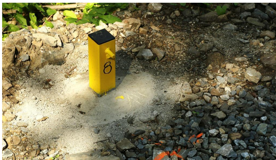
Obr. 2.3.1.11 – Sloupková značka s navařenou konzolkou (typ Tomi-Remont)
