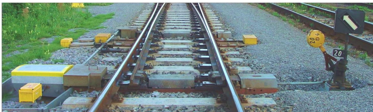
Obr. 4.6.4.2.2 Přestavník a výměník jsou na opačných stranách výhybky
