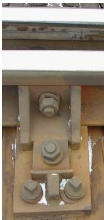
Obr. 4.6.2.3.6 Opornicová opěrka
