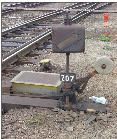
Obr. 4.6.4.2.1 Přestavník i výměník na jedné straně výhybky
