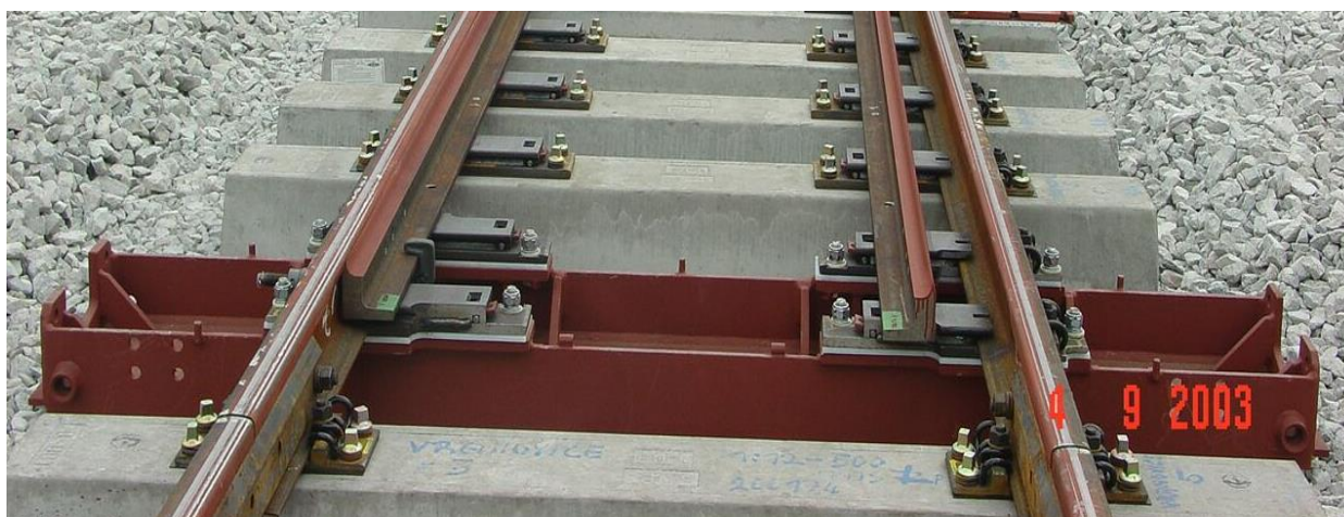
Obr.4.6.4.3.1 Žlabový pražec přírubový.
