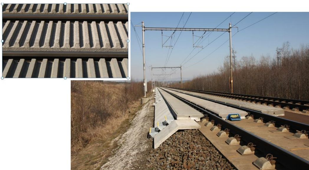
Obr. 4.9.1.2.1 kolejový absorbér na BA (z mezerovitého betonu)
