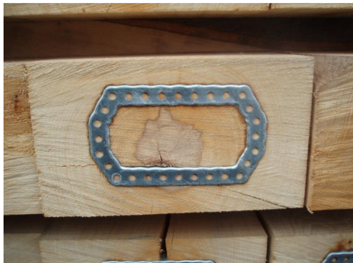
Zajištění čela pražce dutou destičkou
