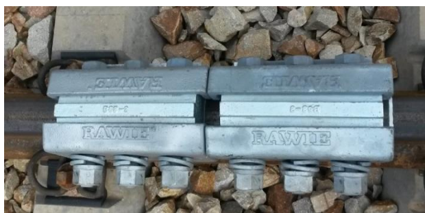
Obr. 8.3.4.4 - Detail brzdňého prvku
