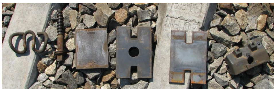
Obr. 4.4.7 Jednotlivé prvky upevnění E 14
