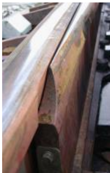
Obr. 4.6.2.5.10 Pohyblivý hrot přiléhající ke křídlové kolejnici
