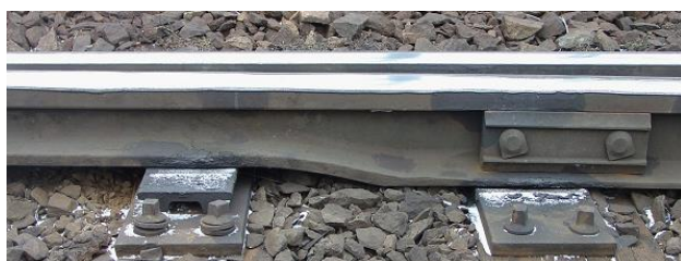
Obr. 4.6.2.2.2 Překování profilu jazykové kolejnice na profil Vignolovy kolejnice (svar ve volné části jazyka zajištěný spojkou)
