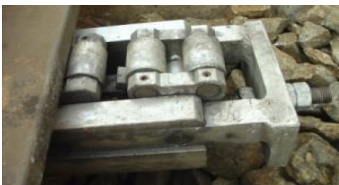
Obr. 4.6.5.1.3 Válečková stolička typu SVV
