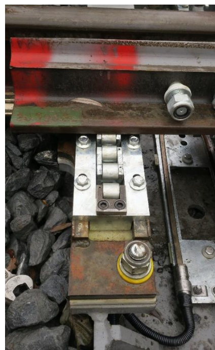
Obr. 4.6.5.1.6 Válečková stolička typu SVV-ZP
