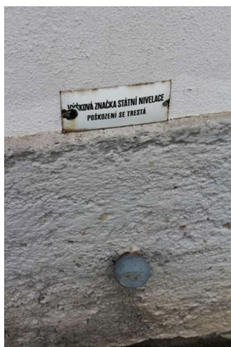
Obr. 2.3.1.14 – Nivelační značka na nádražní budově
