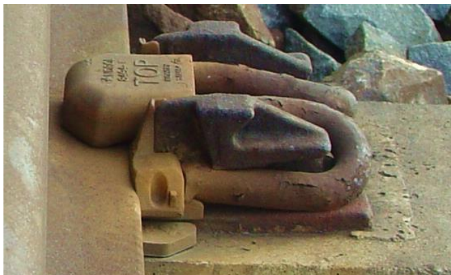
Obr. 4.4.12 Upevnění FC I
