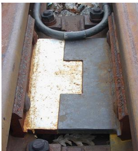
Obr. 4.6.2.3.2 Zádržná opěrka proti putování jazyka výrobce Chládek a Tintěra, dodávány do výhybek generovaných touto firmou
