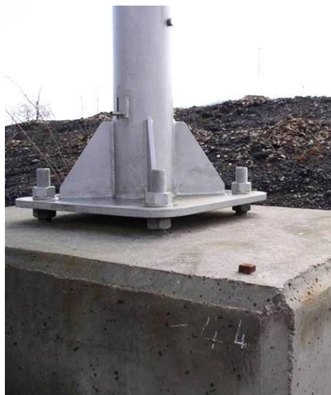
Obr. 2.3.1.9 – Vrtule v betonovém základu a konzole v podpěře TV
