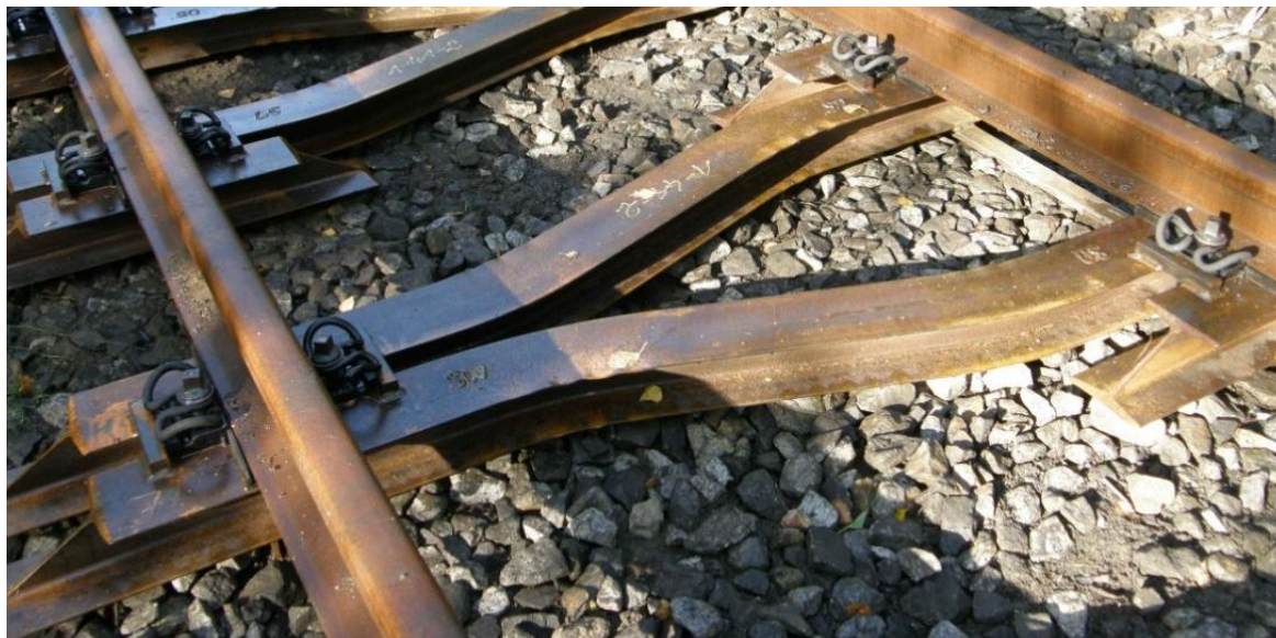
Obr. 4.3.4.1 Ocelový pražec Y - základní
