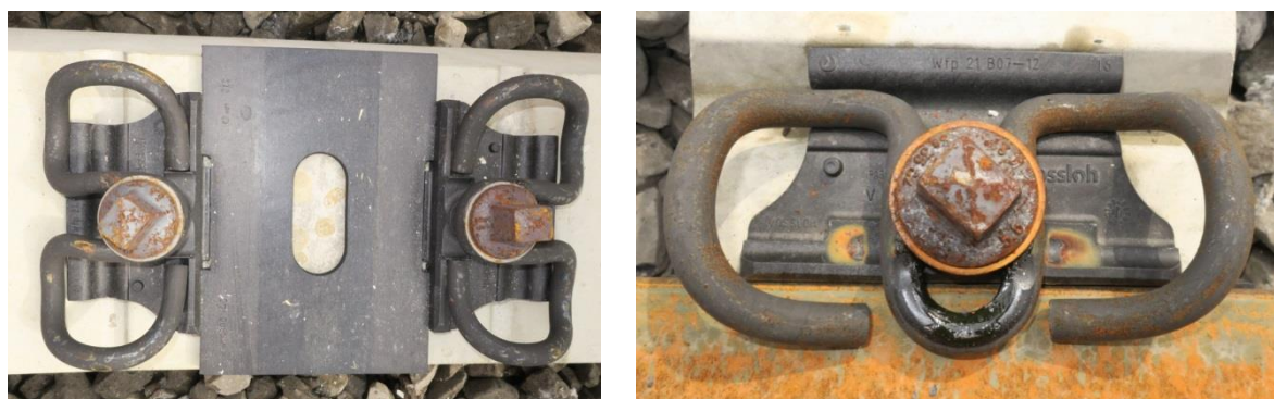
Obr. 4.4.11 Upevnění W 21B07
