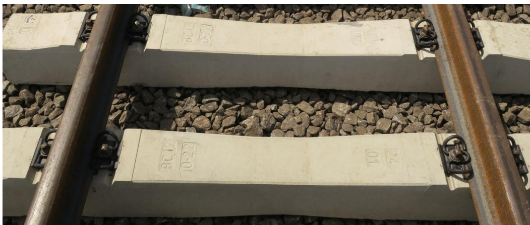
Obr. 4.3.2.12 Pražec BC 12 s rozšířenými úložnými plochami (na foto se standardním upevněním W 14)
