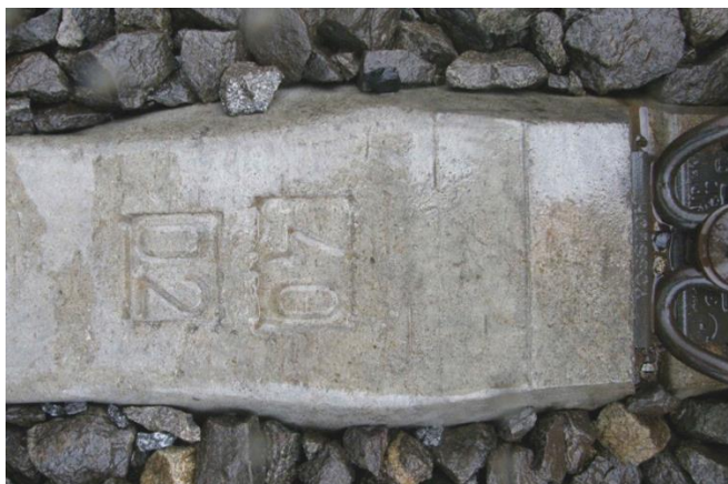
Obr. 4.3.2.18 Značení čísla výrobní formy (40) a pořadí pražce ve formě (02)
