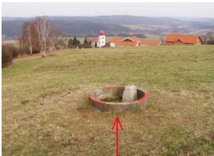
Obr. 2.3.1.15 – Ochrana betonovou skruží
