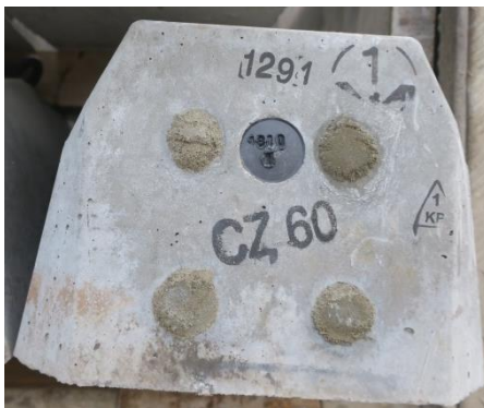
Obr. 4.3.2.22 Mechanické značení na hlavě pražce – alternativní provedení
