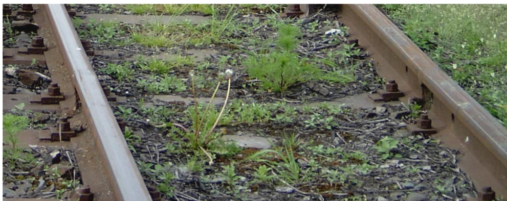
Obr. 4.4.1 Tuhé šroubové upevnění pomocí plochých svěrek na ocelových pražcích (historický typ)
