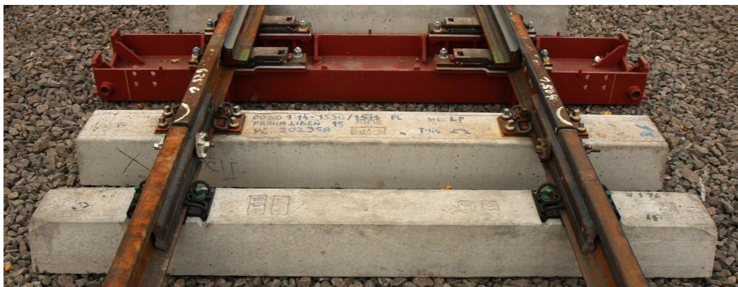
Obr. 4.3.2.10a Pražec BV 08 (v popředí) v porovnání s pražcem VPS (a žlabovým vzadu)
