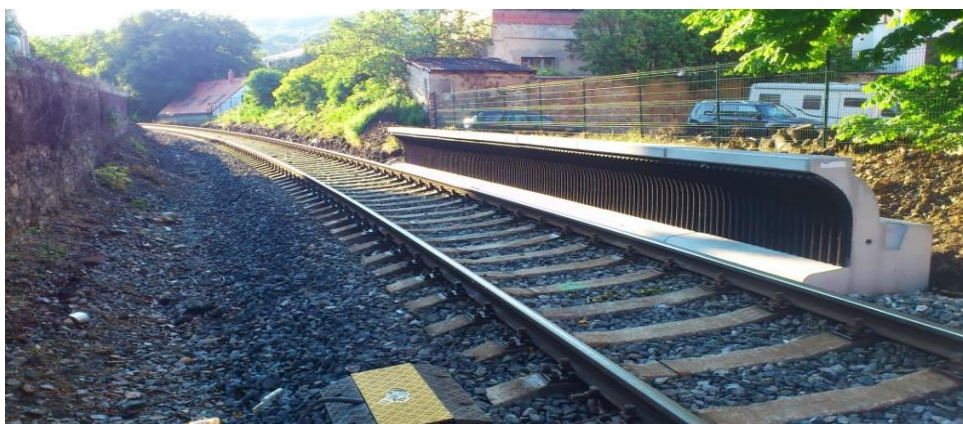
Obr. 3.18.2 - NPC u zast. Praha Hlubočepy
