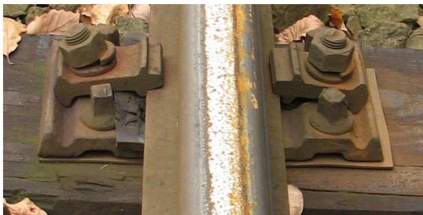
Obr. 4.4.2 Upevnění s rozponovými podkladnicemi na dřevěném pražci
