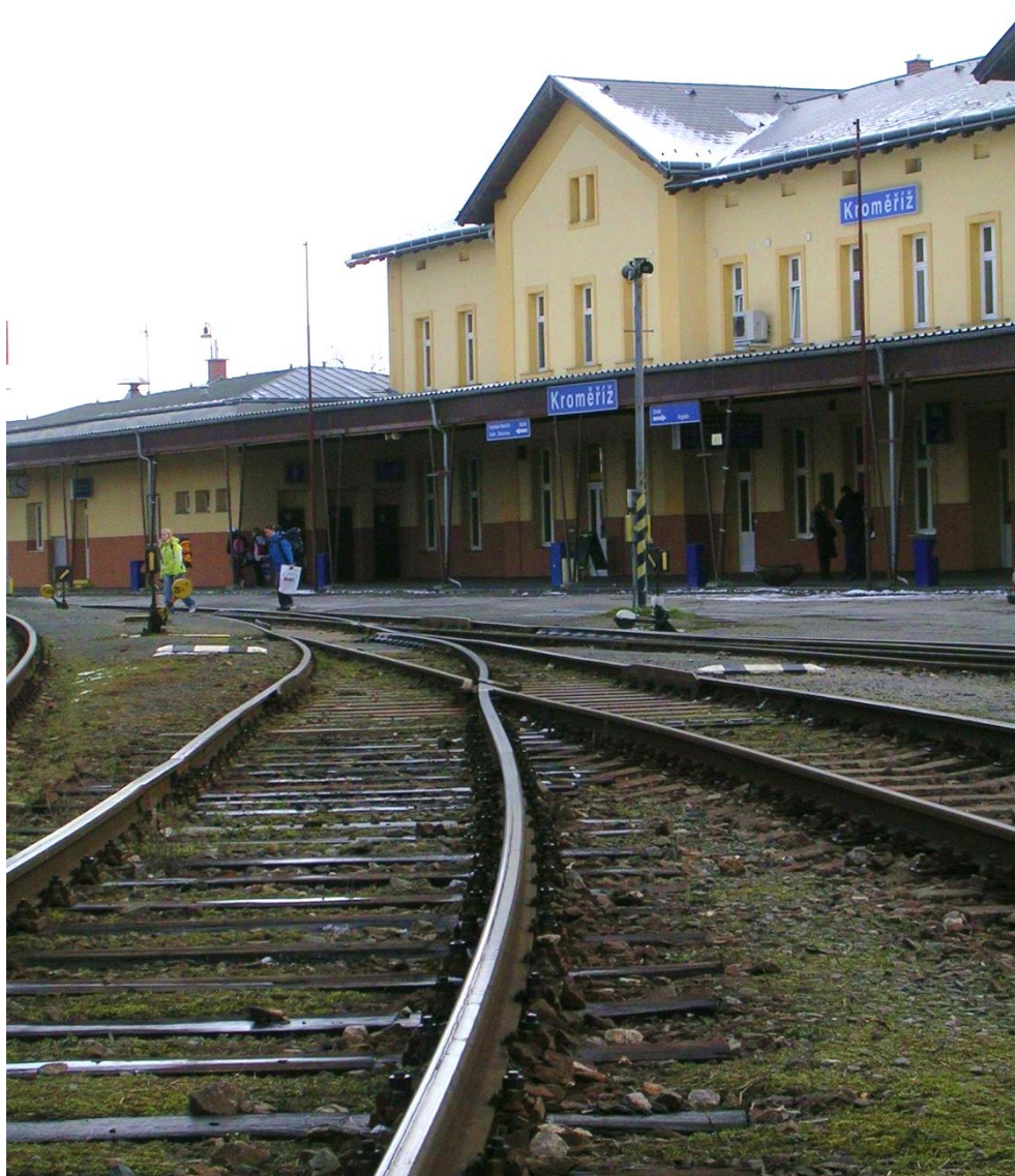
Obrázek 8.2.7.1 - Dnes již historický obrázek z žst. Kroměříž s ne zcela optimálně upravenou křivostí oblouku za výhybkou
