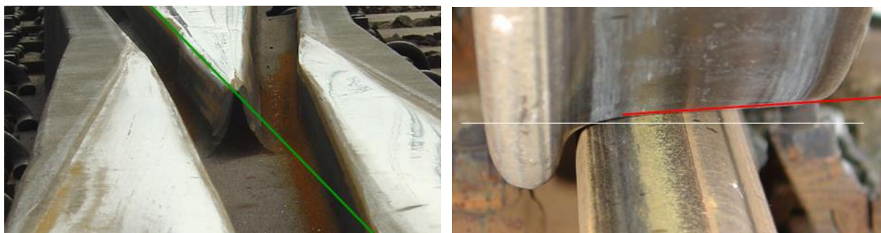
Obr. 4.6.2.5.16 Přerušená pojížděná hrana a konicita kola
