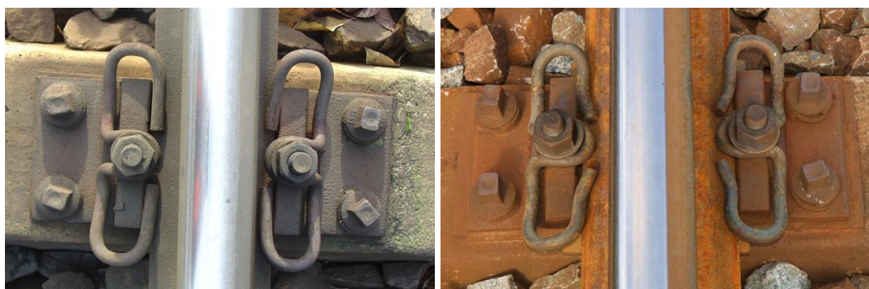
Obr. 4.4.14 Upevnění KS se svěrkami Skl 24 (vlevo původní - vpravo nový tvar svěrky)
