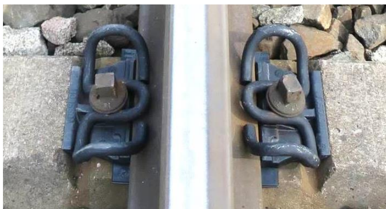
Obr. 4.4.9 Upevnění W 30HH
