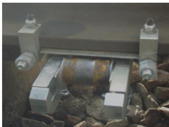
Obr. 4.6.5.1.4 Válečková stolička typu VSV firmy AŽD Praha s.r.o.
