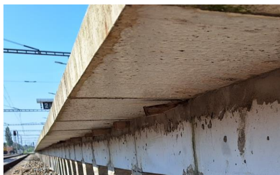
Obr. 3.14.6 - Konzolová deska – vada převibrování a segregace složek betonu
