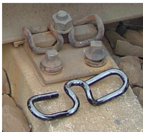
Obr. 4.4.15 Porovnání svěrky Skl 24 (původního tvaru) se svěrkou Skl 12 v upevnění KS
