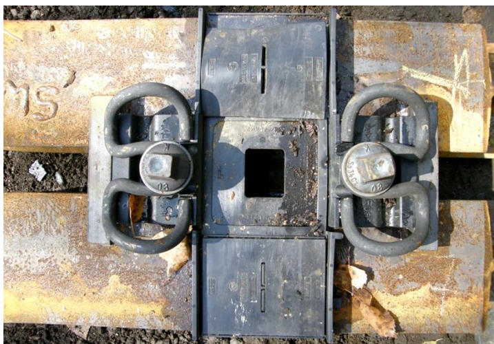
Obr.4.4.13 Upevnění S 15 pro ocelové pražce Y (v předmontážní poloze)
