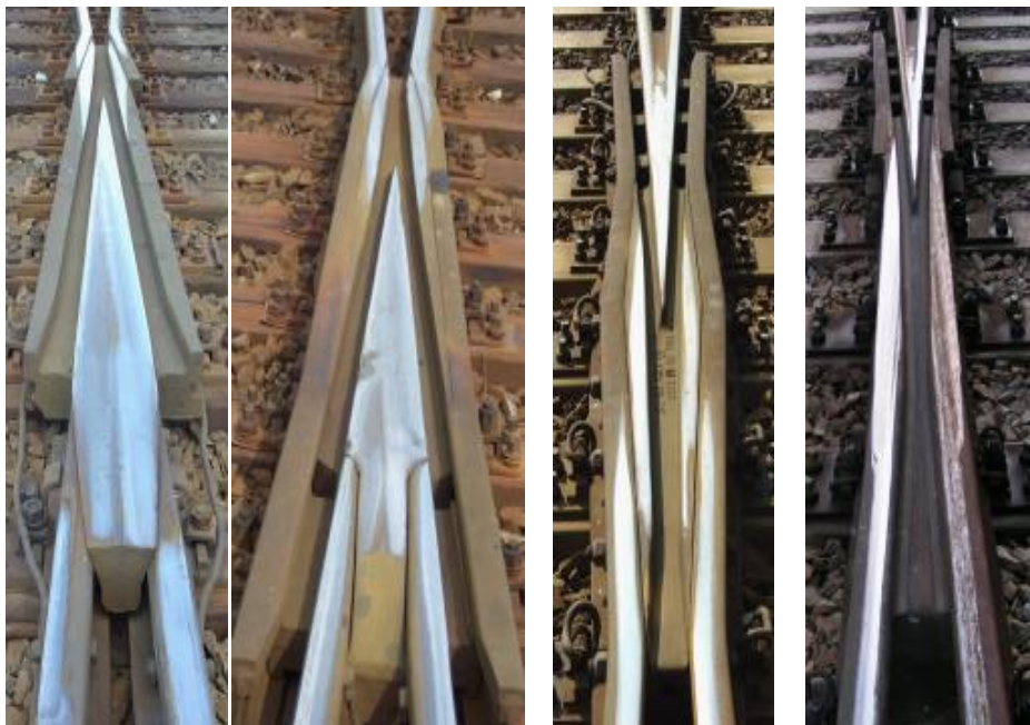
Obr. 4.6.2.5.6 Srdcovky s částmi z odlévané oceli se šikmými styky s odlitky z ČR a Polska
