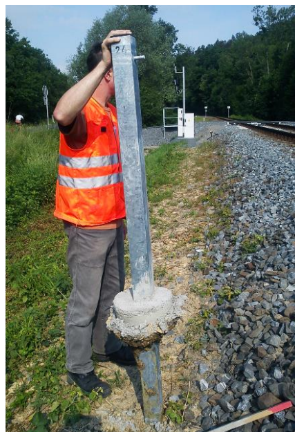
Obr. 2.3.1.13 – Zajišťovací značka po odkrytí
