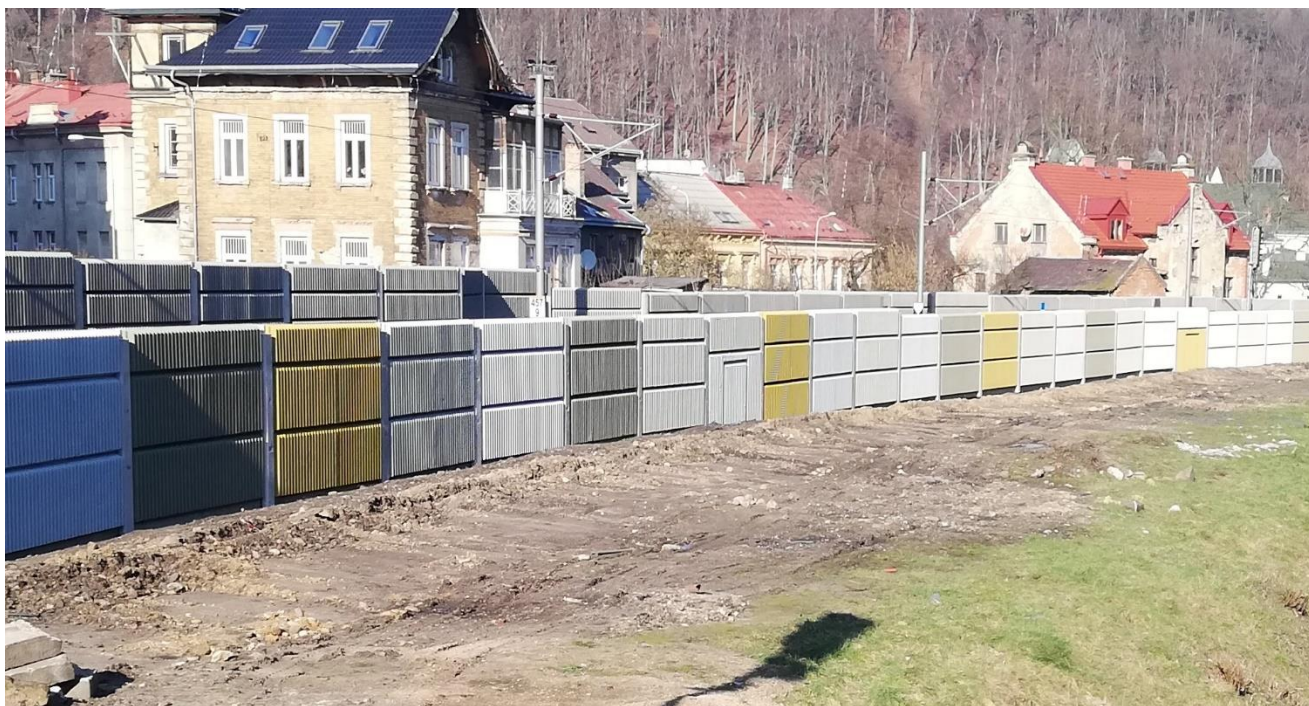
Obr. 3.18.1 - Příklad protihlukových stěn ze železobetonu, oboustranně pohltivých
