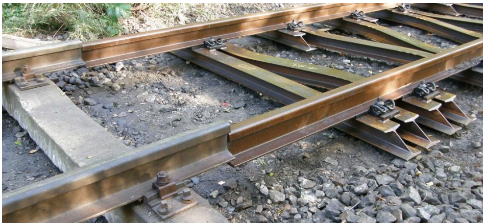
Obr. 4.3.4.2 Ocelový pražec Y – přechodový
