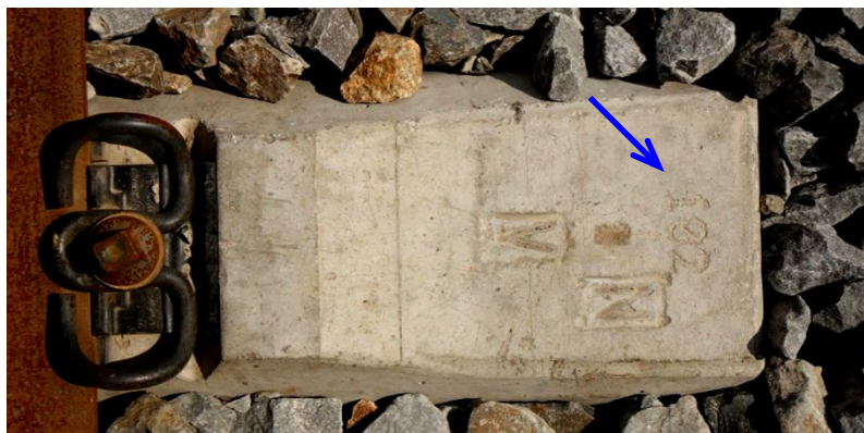
Obr. 4.3.2.21 Mechanické značení na hlavě pražce (3-místný kód značí číslo kalendářního týdne a dne výroby v daném roce; v případně vícesměnného provozu výroby obsahuje ještě dodatečný znak, např. „o“ jako odpolední směna)
