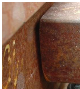
Obr. 4.6.6.2 Doléhání stojiny jazyka k opěrce
