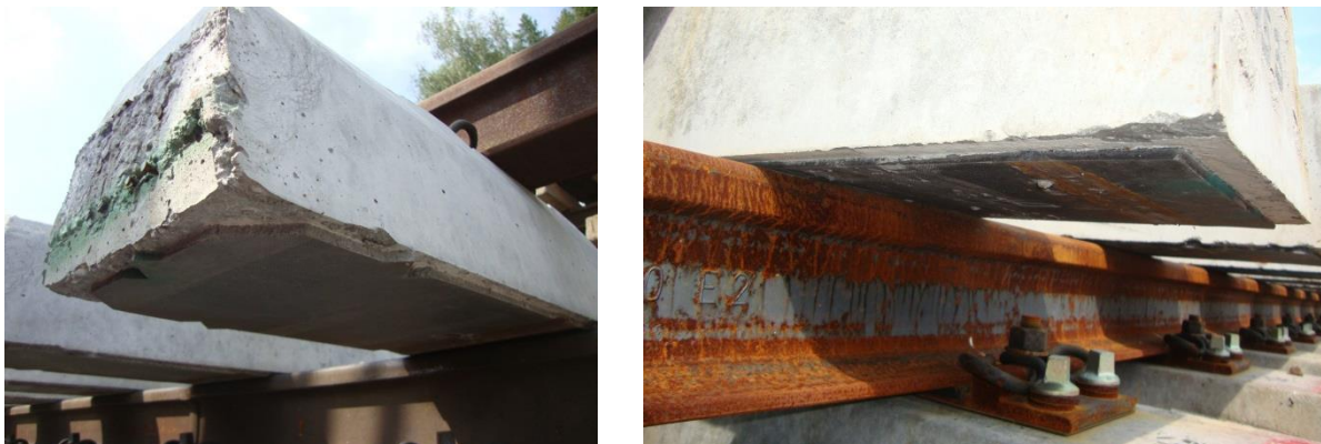
Obr. 4.3.2.16 Příčné a výhybkové pražce se zabudovanými USP
