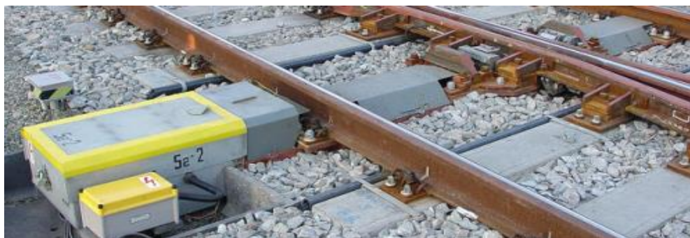
Obr. 4.6.2.5.13 Přestavník a přírubový žlabový pražec
