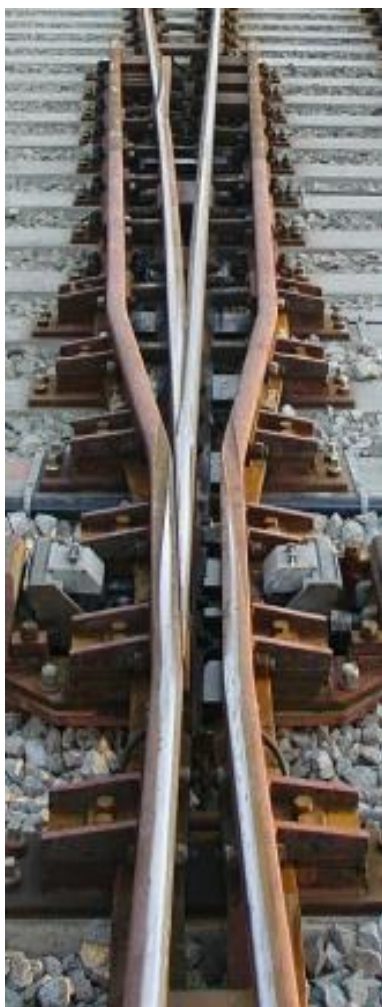
Obr. 4.6.2.5.11 Srdcovka s pohyblivým hrotem
