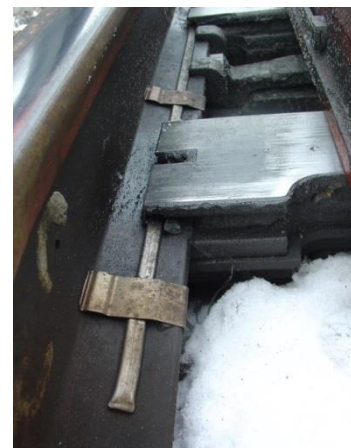
Obr. 4.6.5.1.10 Topná tyč pod nosem kluzné stoličky
