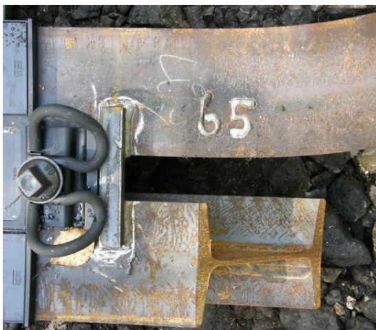
vzdálenost podpor kolejnic (650 mm)
