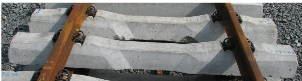
Obr. 4.3.2.7 Srovnání pražce B 91S/2 pražec B 91S/1 (vzdálenější pražec)
