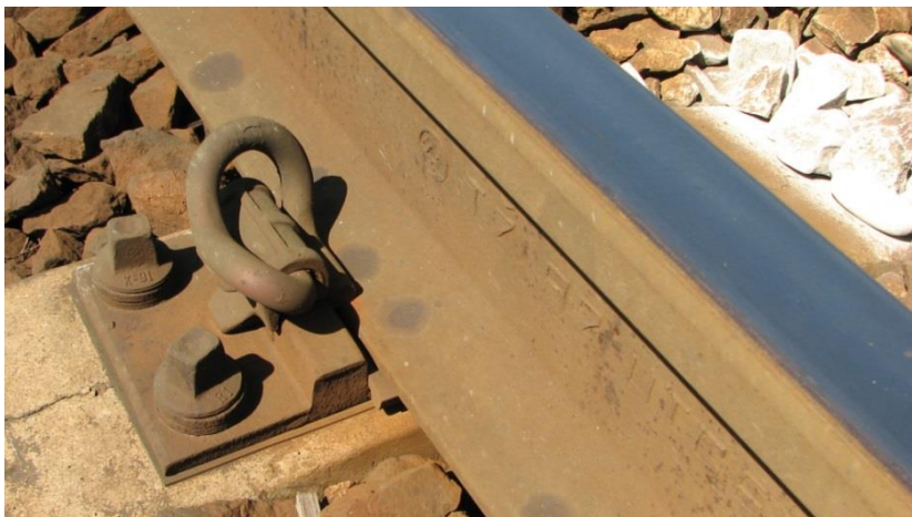
Obr. 4.4.16 Upevnění „Ke“ s žebrovou pokladnicí na betonovém pražci SB 8P
