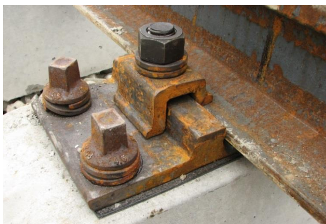
Obr. 4.4.3 Upevnění typu „K“ s tuhou svěrkou ŽS 4
