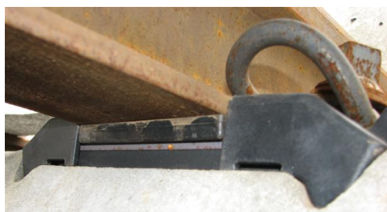
Obr. 4.4.6 Správná montáž upevnění E 14 (vodící vložka s výstupkem musí být umístěna uvnitř koleje)
