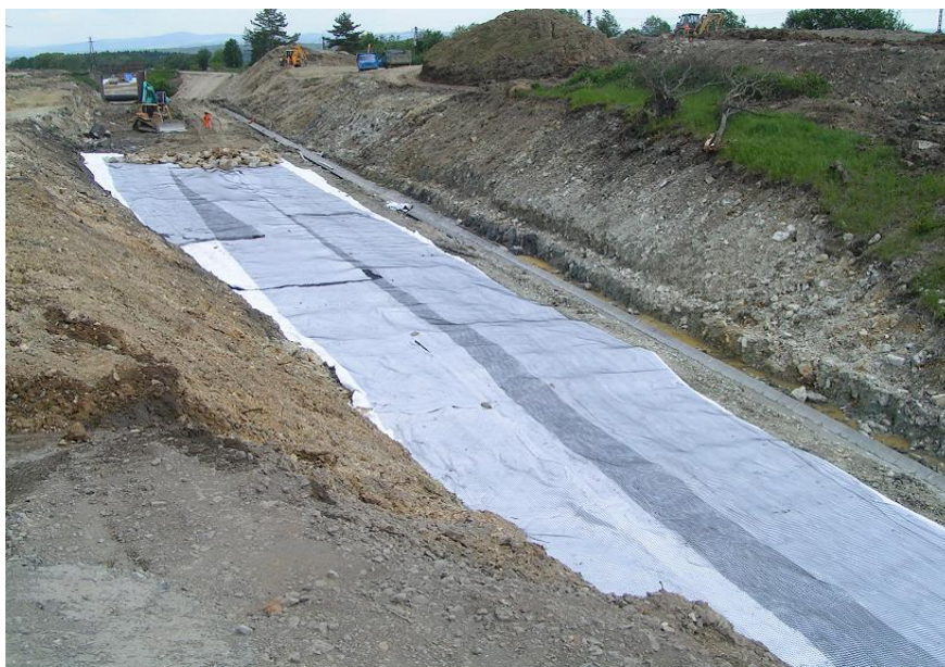
Obr. 3.9.3 - Stabilizace neúnosného podloží vkládáním geotextílie s geomřížkou
