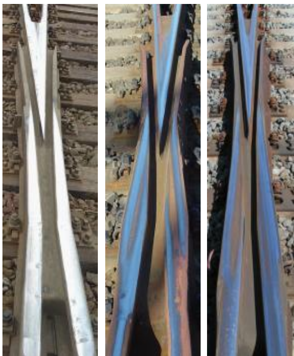
Obr. 4.6.2.5.4 Celolité srdcovky z odlitků Třinec, Manoir a Bari
