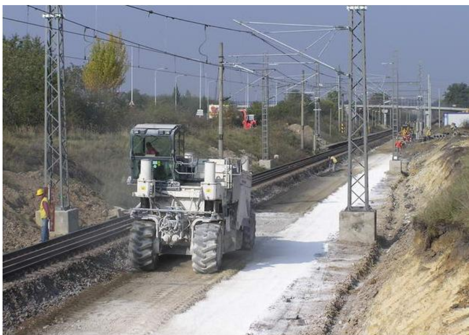
Obr. 3.9.2 - Použití těžké zemní frézy při zlepšení zeminy zemní pláň vápnem
