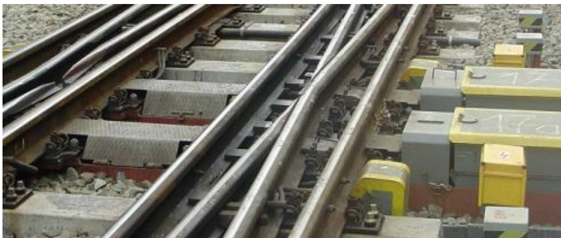
Obr. 4.6.2.5.14 Dvojité srdcovky s pohyblivými hroty
