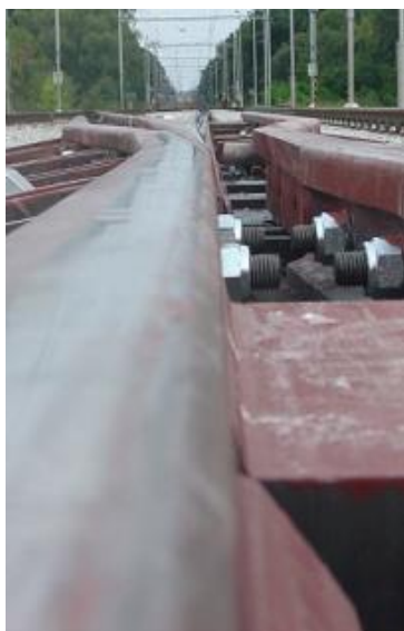
Obr. 4.6.2.5.9 Nepřerušená pojízdná hrana
