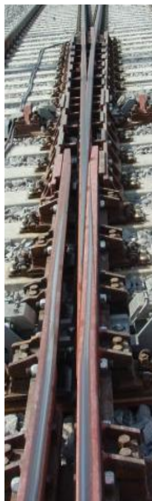
Obr. 4.6.2.5.12 Srdcovka s pohyblivým hrotem tvaru 60-1:26,5-2500
