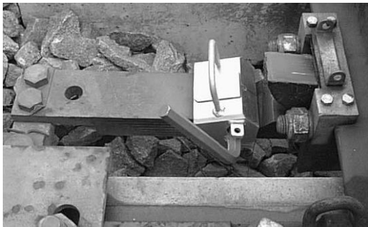
Obr. 4.6.4.2.10 Přenosný zámek čelistového závěru – zabraňuje vyklesnutí háku a omezuje pohyb závorovací tyče
