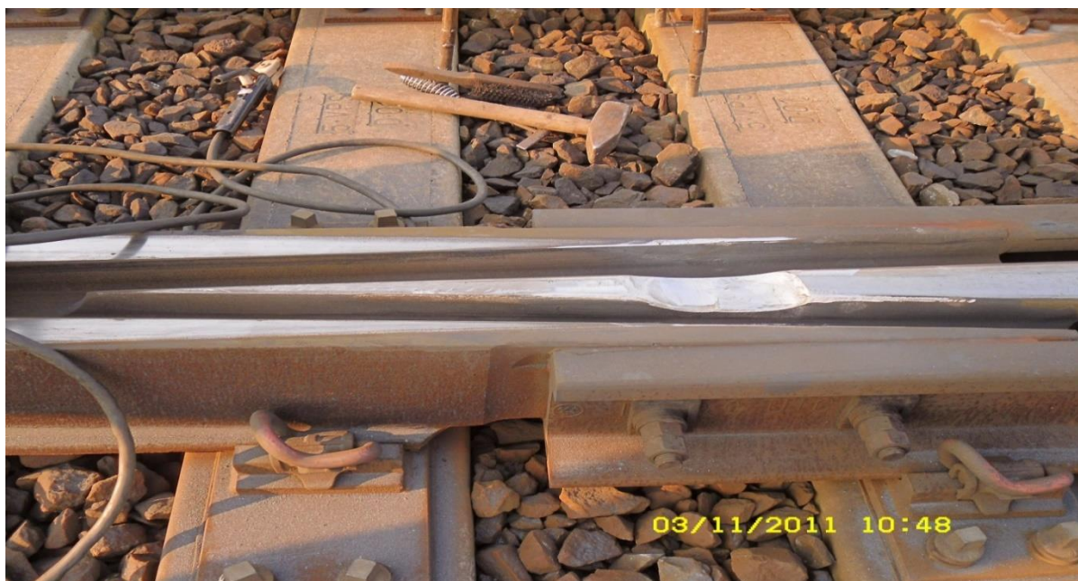
Obr. 7.2.2 Vybroušená vada před opravou navařením
