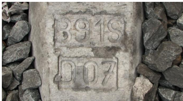
Obr. 4.3.2.17 Značení typu pražce a výrobního závodu s rokem výroby
