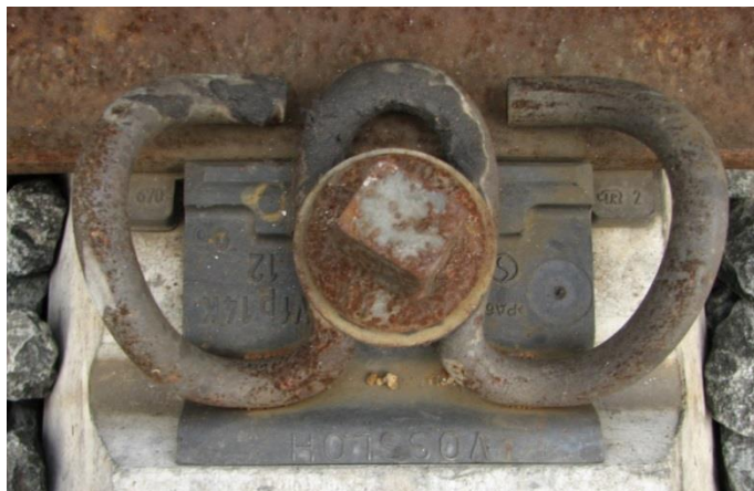
Obr. 4.4.5 Upevnění W 14 se svěrkou Skl 14
