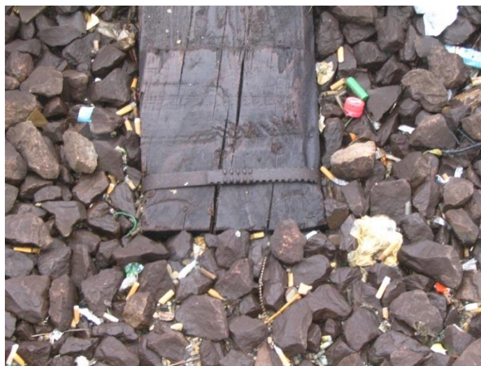
Zajištění čela pražce ocelovou páskou
