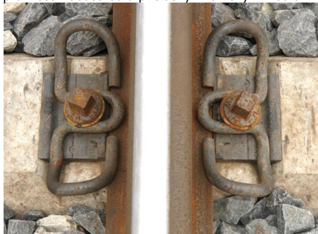
Obr. 4.4.8. Upevnění W 28NT
