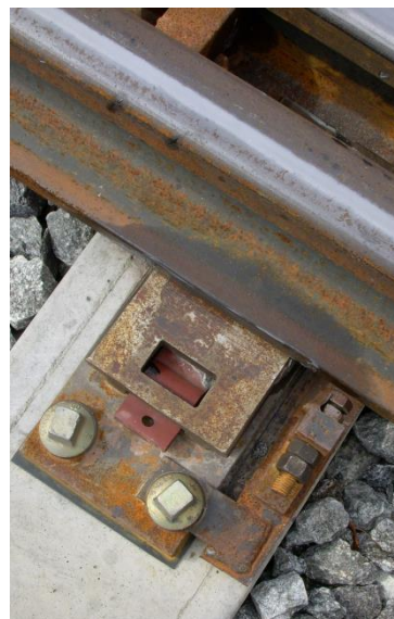
Obr. 4.6.5.1.15 Omezovač polohy jazyka
