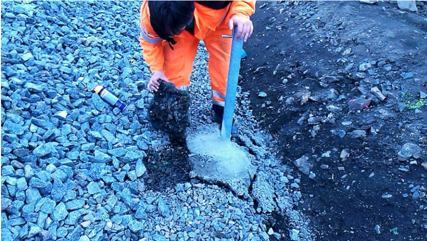
Obr. 2.3.6.5 – Nestabilní zajišťovací značka, která navíc nemá schválené TPD
