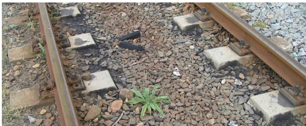
Obr. 4.3.2.1 Pražec DZP 10-T5 (RS pražec)
