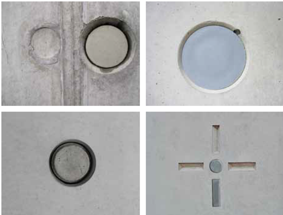
(23) Obr. F.2 – Různé způsoby uzavření spínacích otvorů
